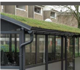
Bågformat tak med sedum
